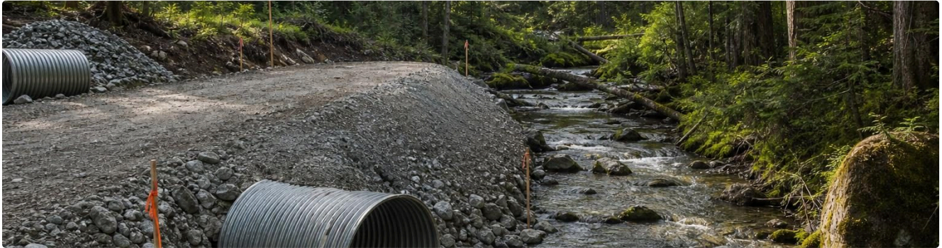
Un proyecto de camino de grava se detiene al borde de un arroyo en el bosque, con árboles y materiales para construir caminos visibles.
