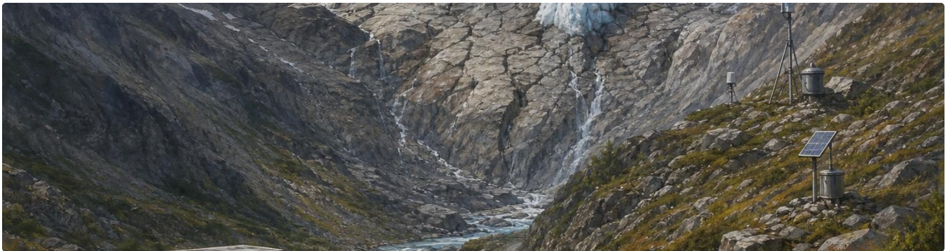
Un valle de montaña con infraestructura debajo de un glaciar que retrocede y una ladera rocosa agrietada, con equipos de monitoreo instalados.
