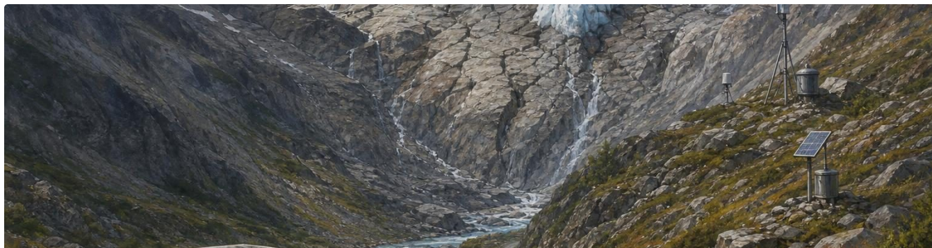
Un valle de montaña con infraestructura debajo de un glaciar que retrocede y una ladera rocosa agrietada, con equipos de monitoreo instalados.
